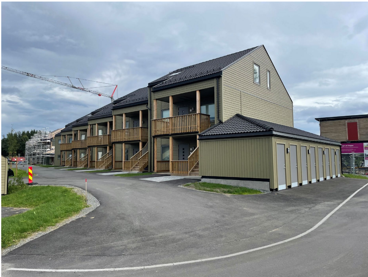
Foto: Gluggeløkka på Steglet under ferdigstilling august 2025, i regi av Trysilbygg.
