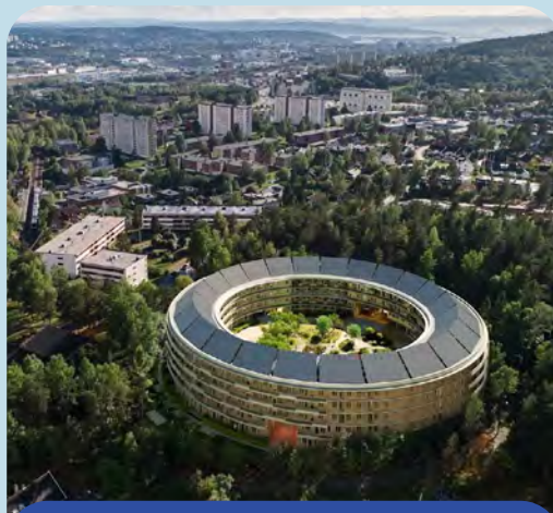
Første spadetak tas og bygging igangsettes på prosjektet Oen på Rødtvedt i Oslo.
