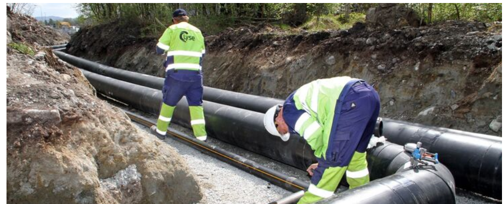
Utvidelse av hovedinfrastruktur for fjernvarme. Foto Ingvild Ween
