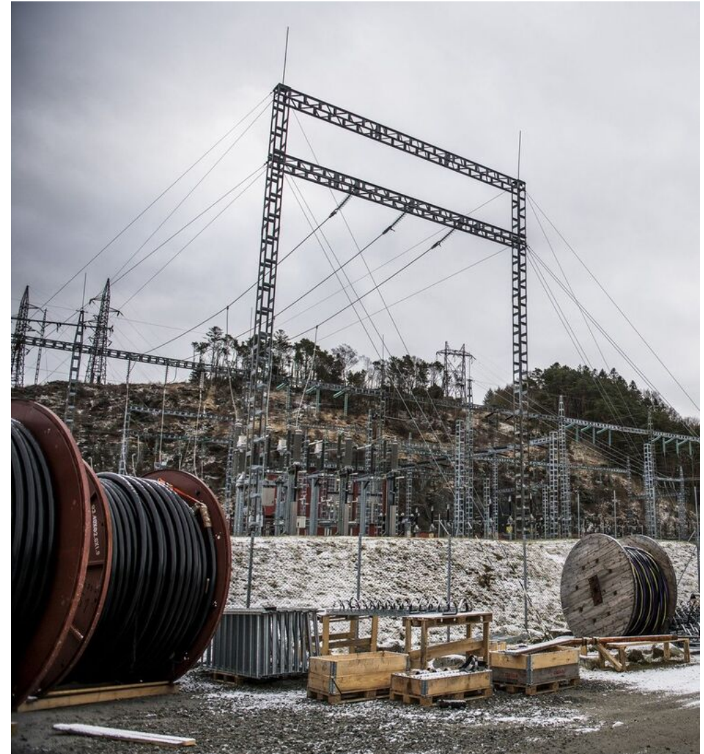
Situasjonsbilde fra Tronsholen transformatorstasjon.
