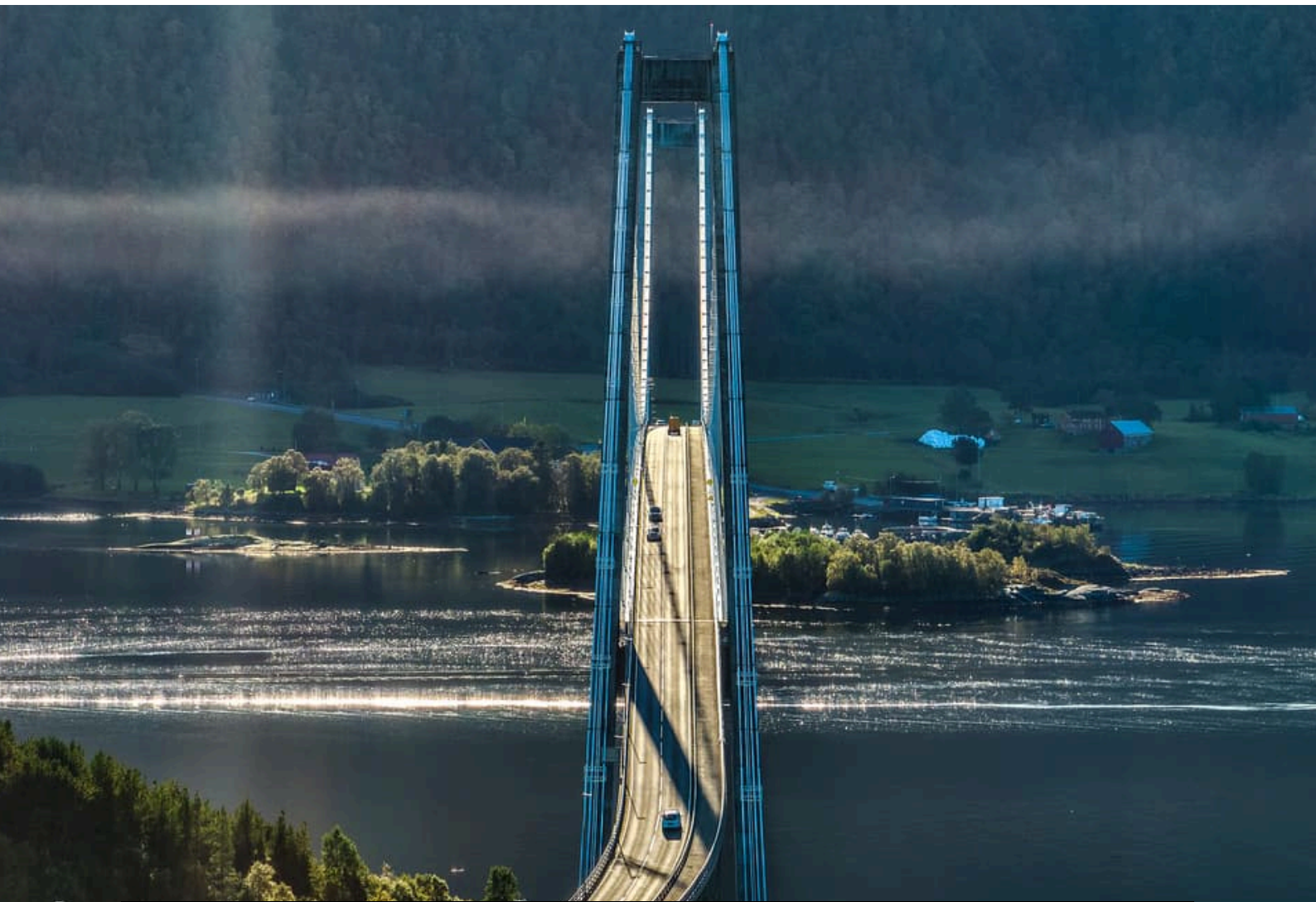
Gjemnessundbrua på Krifast
