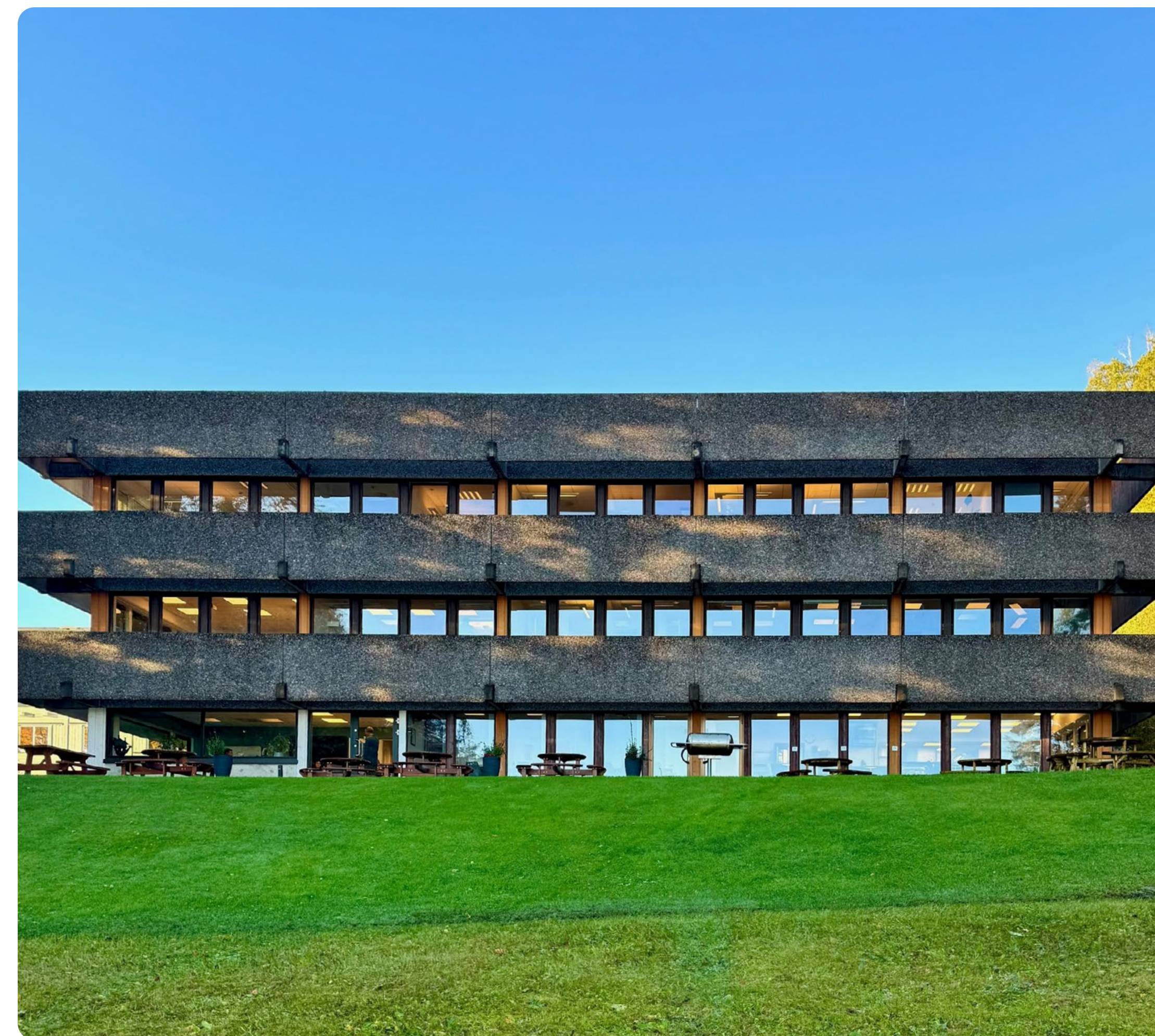
Veas administrasjonsbygg fra 1982 skal rehabiliteres, og det skal i tillegg bygges to nye etasjer.
