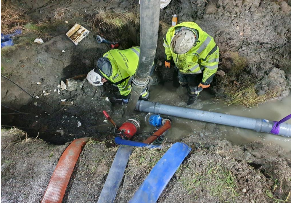
Reparasjonsarbeid etter vannlekkasje. Foto: Sandefjord kommune.
