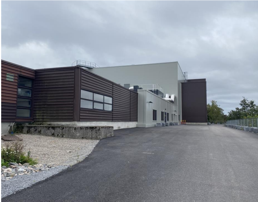
Enga renseanlegg - nytt biologisk rensetrinn. Foto: Sandefjord kommune.
