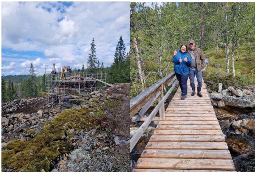
Restaurering Malså gruver - et fornøyd kulturkontor v/Marian Lyngsaunet og Frode Strand på befaring
