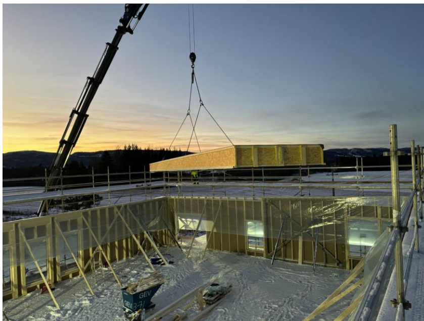
Nye Stiklestad skole tar form. Foto: Grande Entreprenør
