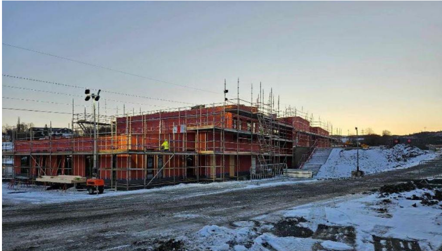
Nye Vinne barnehage. Foto: Grande Entreprenør
