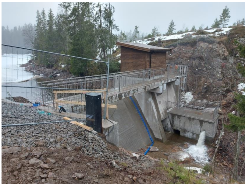
Foto: Kommunalteknikk – ny Tisjøen dam
