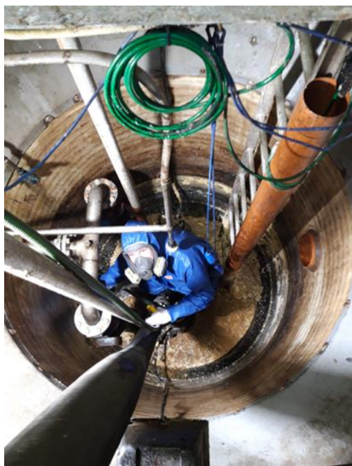
Foto: Kommunalteknikk – sumpvedlikehold på avløpspumpestasjon
