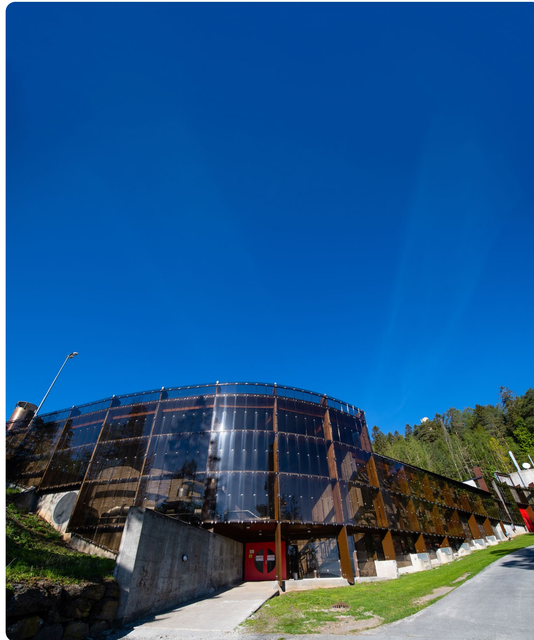
Bak denne glassfasaden ligger de fire utråtningstankene der avløpsslam blir til biogass etter 21 dager.
