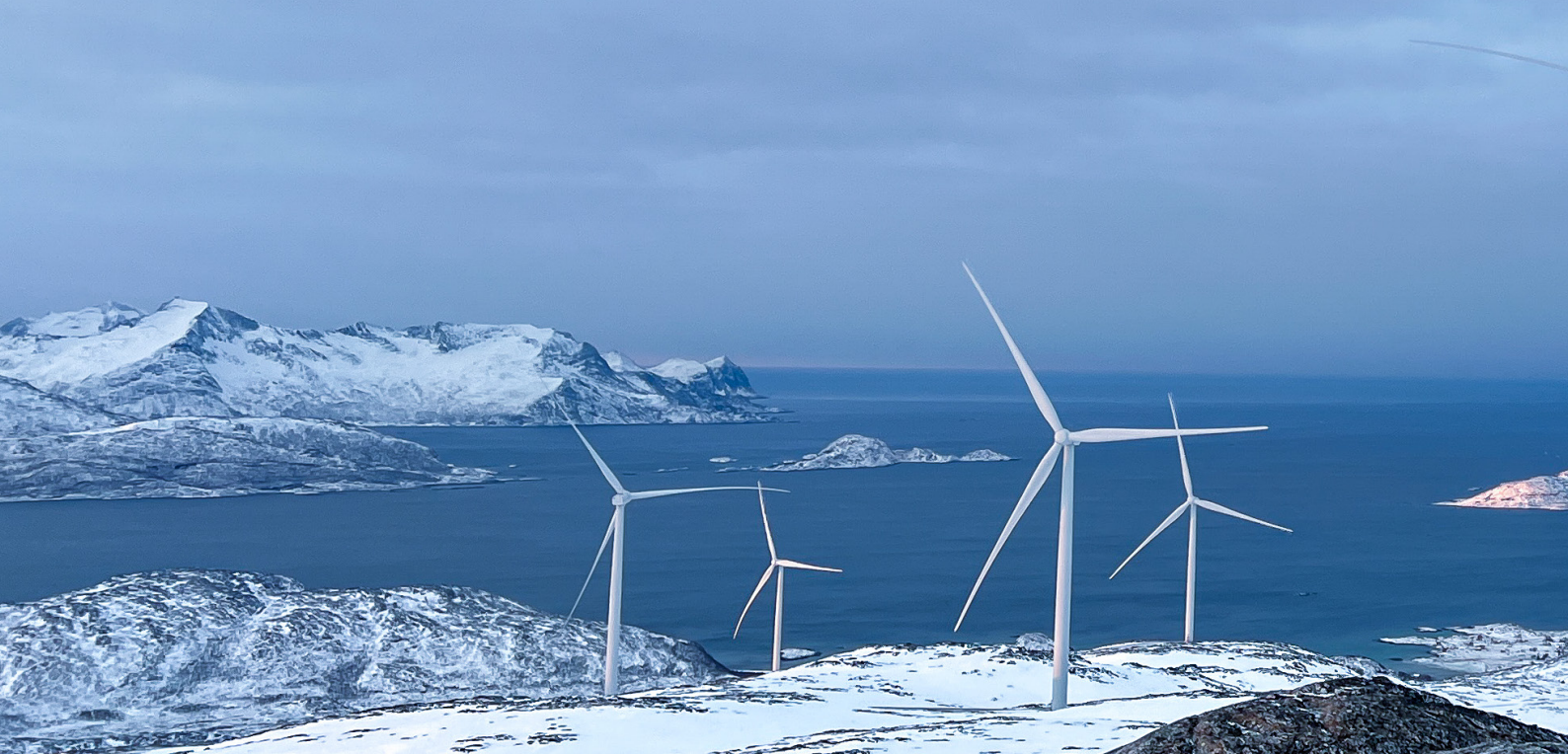
Vindparken Raudfjell i Tromsø
