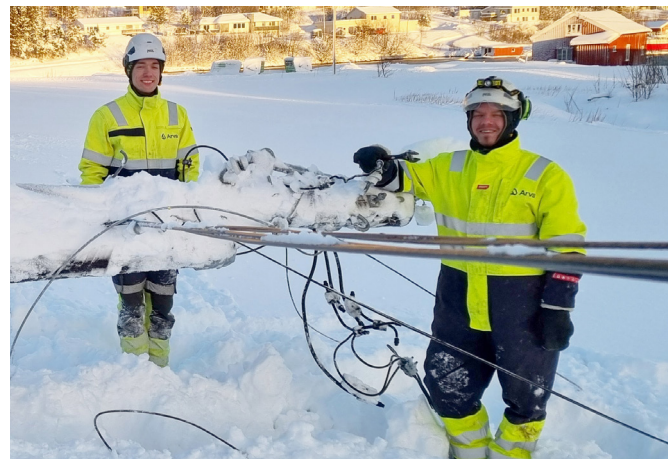
↑ Knekt stolpe på Stonglandseidet på Sør-Senja. Montør Daniel Nergård og lærling Jeremias Nilsen i gang med gjenoppbygging. Foto: Arva
