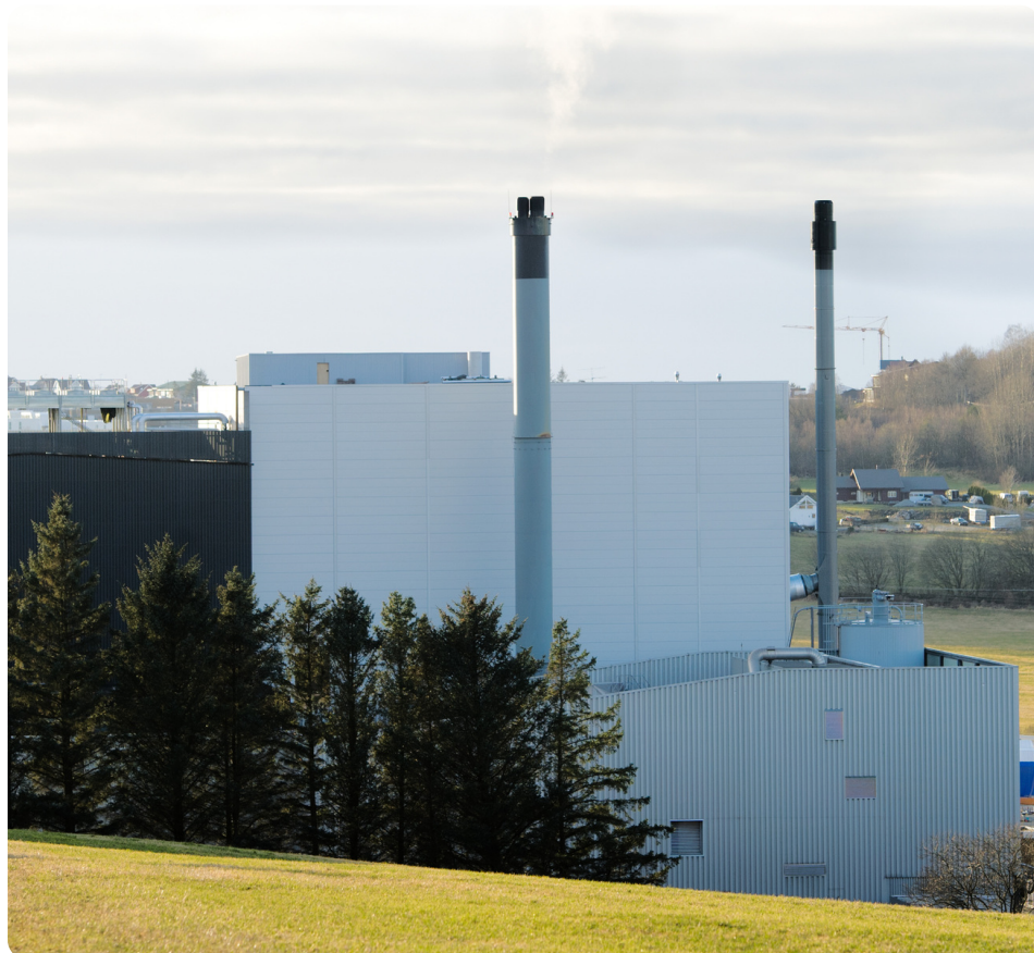
Bruk av spillvarme fra Forus energigjenvinning er en klimavennlig løsning, ettersom ingen "nye" energikilder brukes til varmeproduksjon Foto: Jan Inge Haga.
