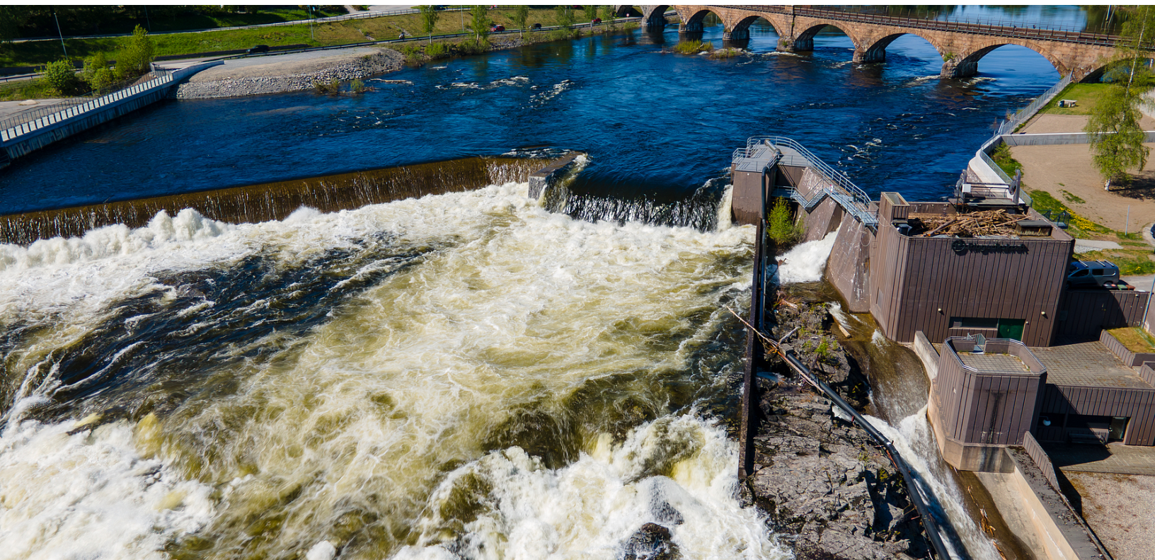
Hønefossen og kraftstasjonen Hønefoss II i vårflommen 2024
