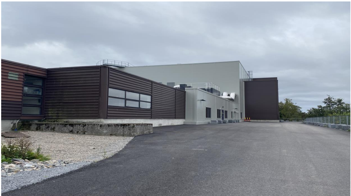
Enga renseanlegg - nytt biologisk rensetrinn. Foto: Sandefjord kommune.
