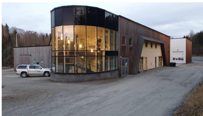
Prosjekt Bårilidalen renseanlegg avsluttes i regnskapet for 2023.
