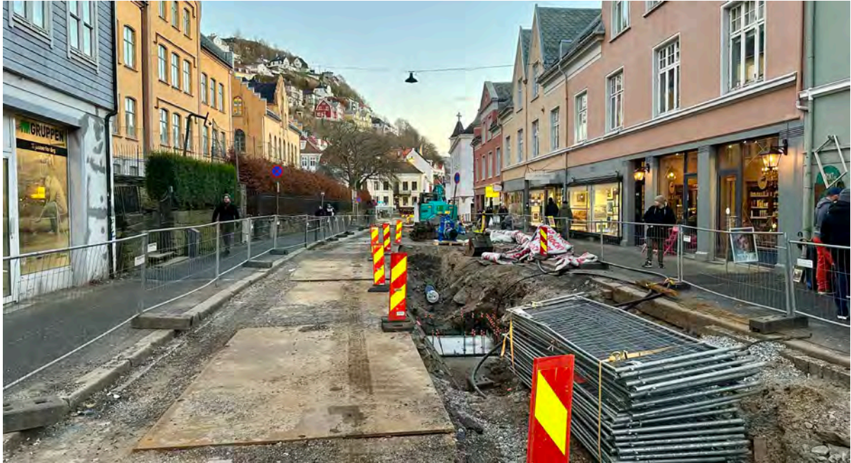
Arbeid med fornying hovedvannledninger i Øvregaten. Foto: Trude Haugen
