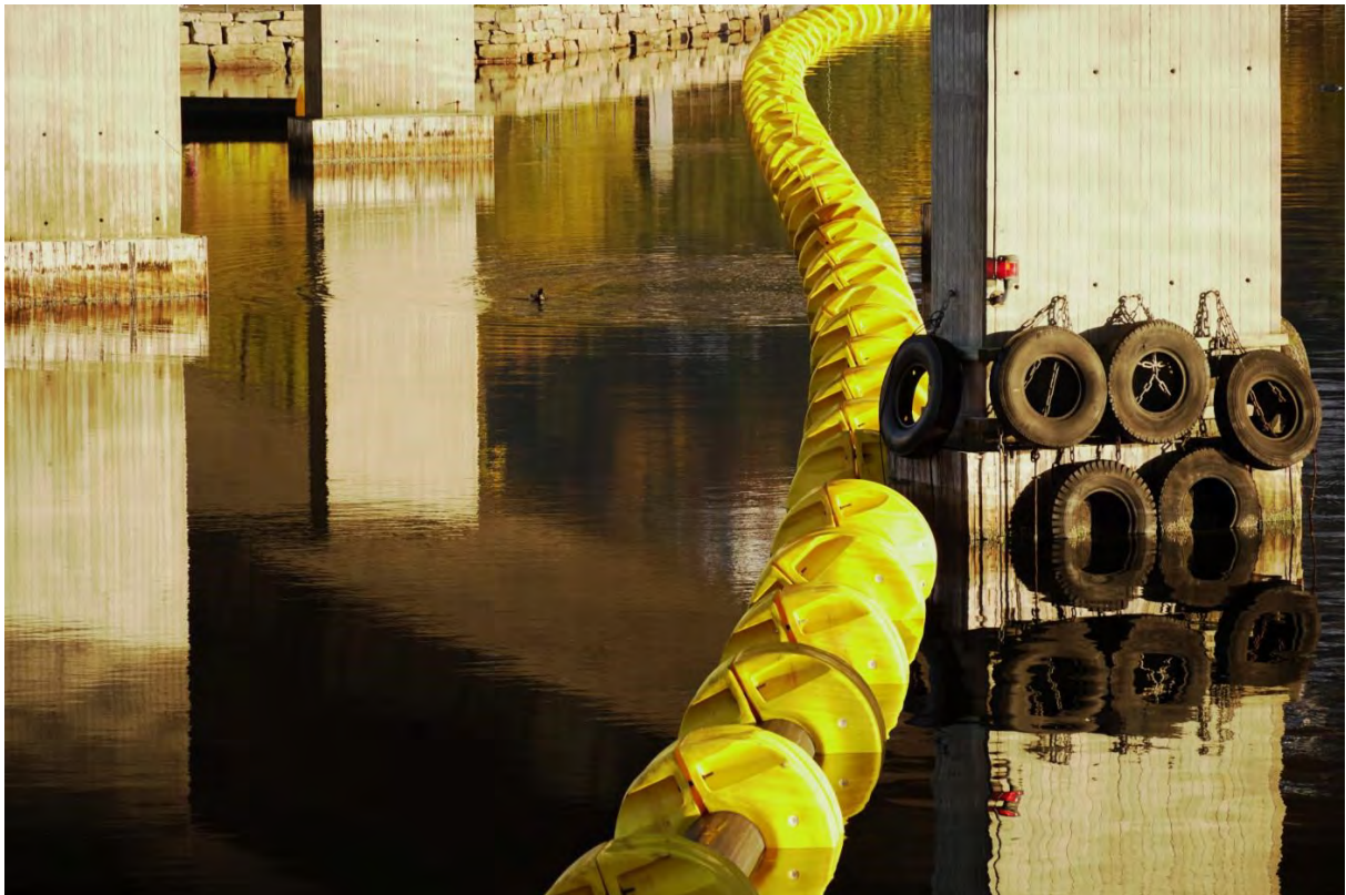
Sanden som blir til ny sjøbotn blir frakta gjennom denne slangen. Foto: Håvard Prestegården
