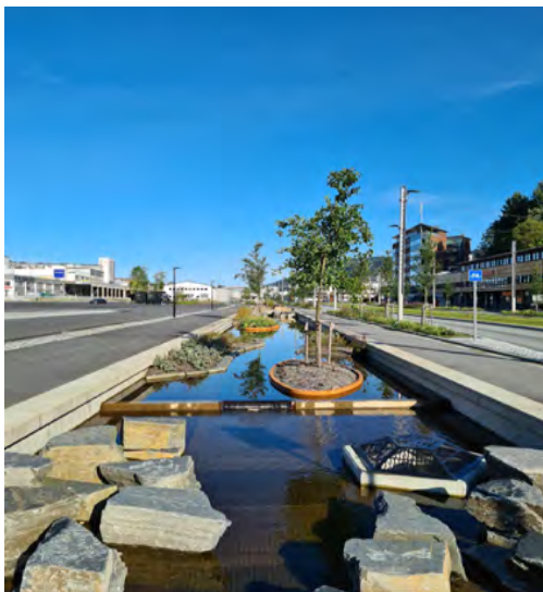
Kanalen i Mindemyren langs bybanen, overvannshåndtering. Foto: Sigrid Teige Øye
