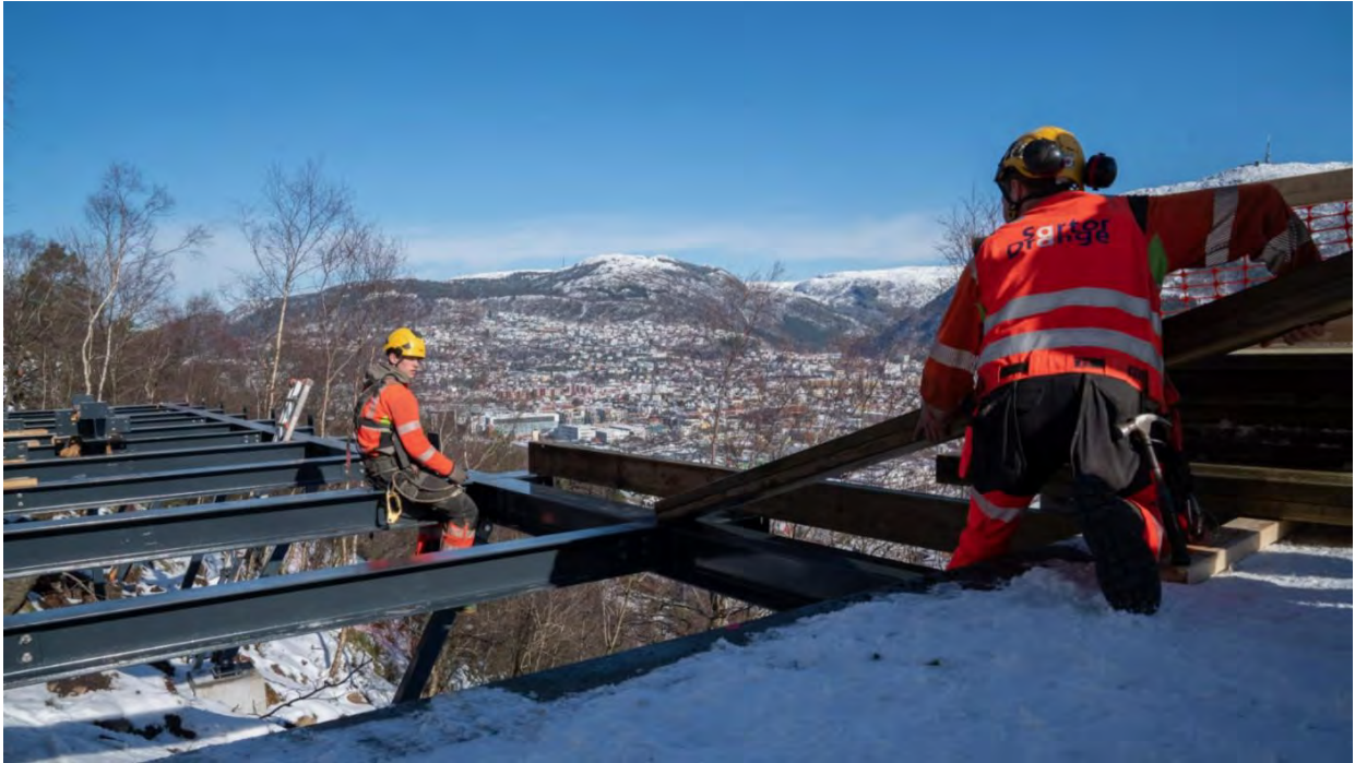
Konstruksjon av gangbrua i Løvstien i mars 2023. Foto: Margrethe Vikan Sæbø
