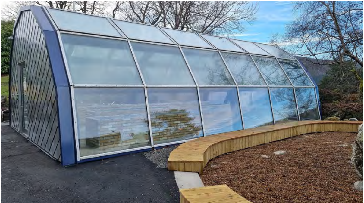
Dette drivhuset ved Bergen inkluderingscenter er laga av ombruksmateriale. Glasstak, dører og teglstein frå den tidlegare lærarhøgskulen. Foto: Ola Henning Målsnes
