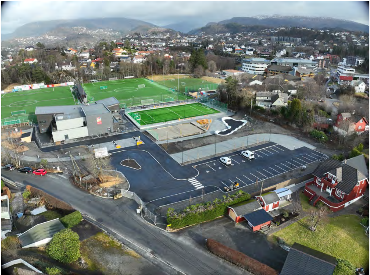
Rekkefølgekravene på Nesttun Idrettspark ble ferdigstilt i 2023. Foto: Rivenes entreprenør og dronefoto Veseth
