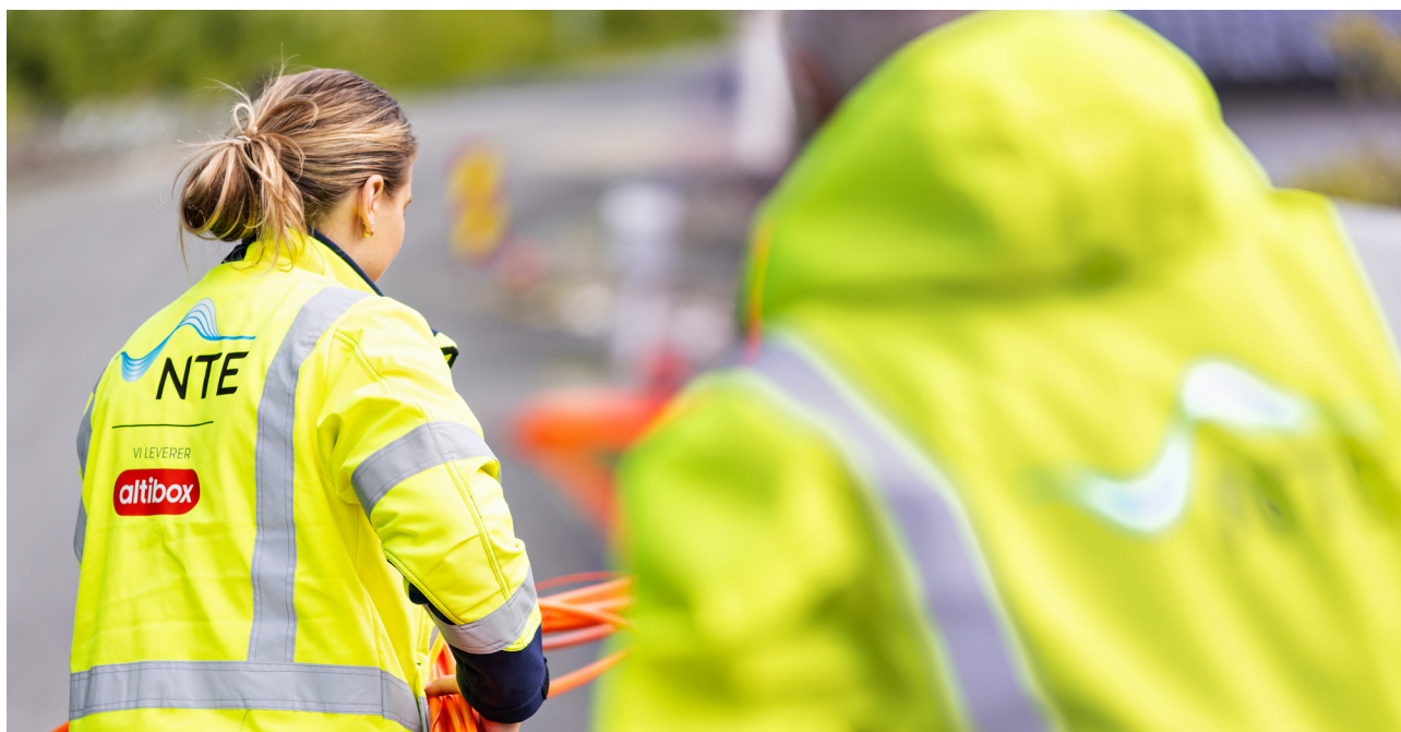
Fiberlegging på Gimse i Melhus
