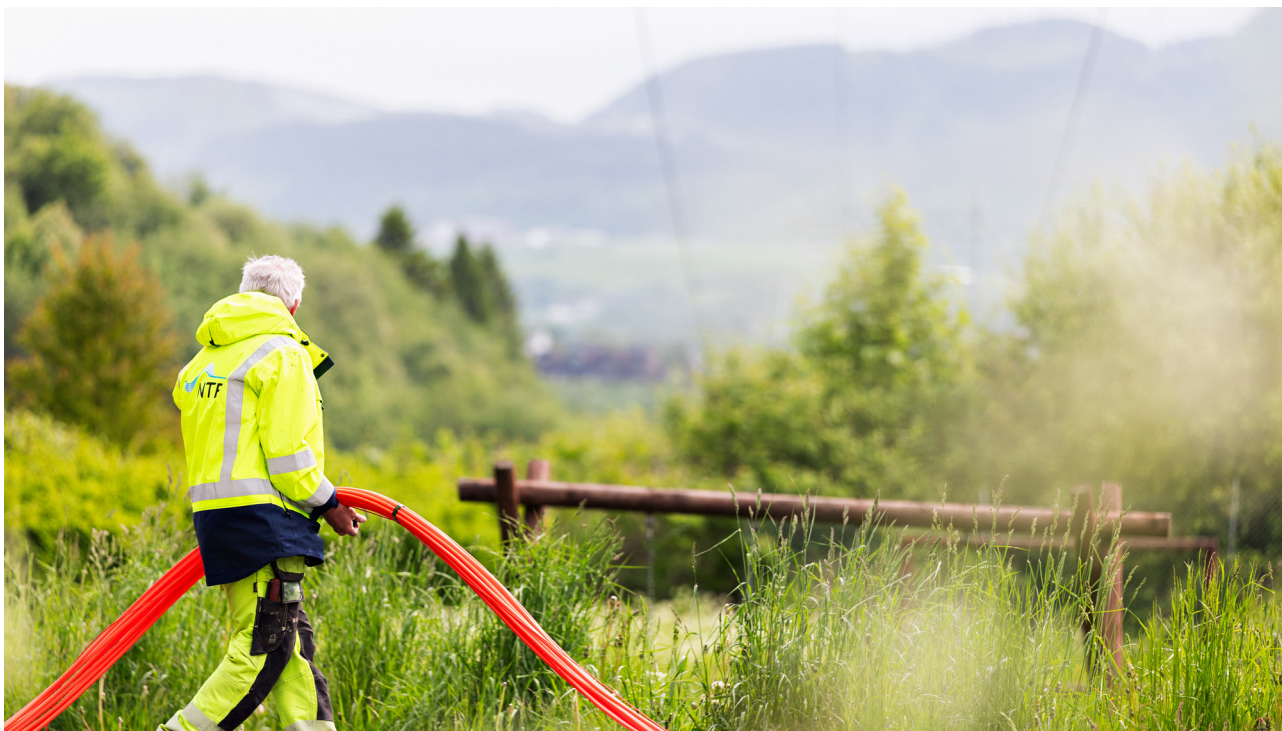
Fiberlegging på Gimse i Melhus
