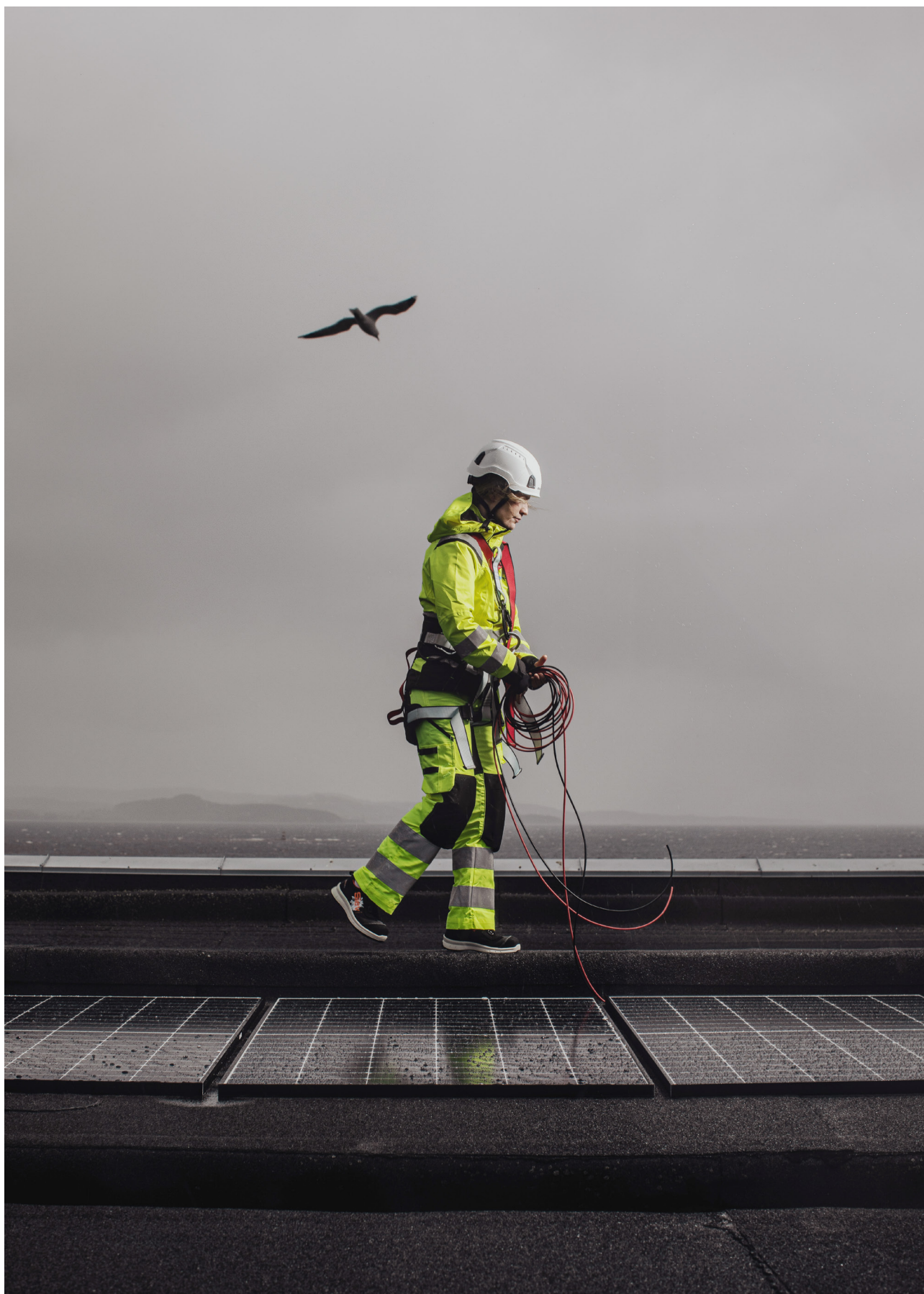
Montering av solcellepanel
