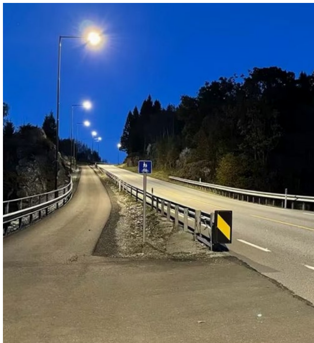
Nytt lysanlegg ved E39 i Sandvikvåg på Fitjar. Her ble det montert LED-armaturer med den nyeste sensorteknologien klargjort for både dimming av lys og aktivitetsstyring. Foto: Lars Olve Hesjedal, Statens vegvesen
