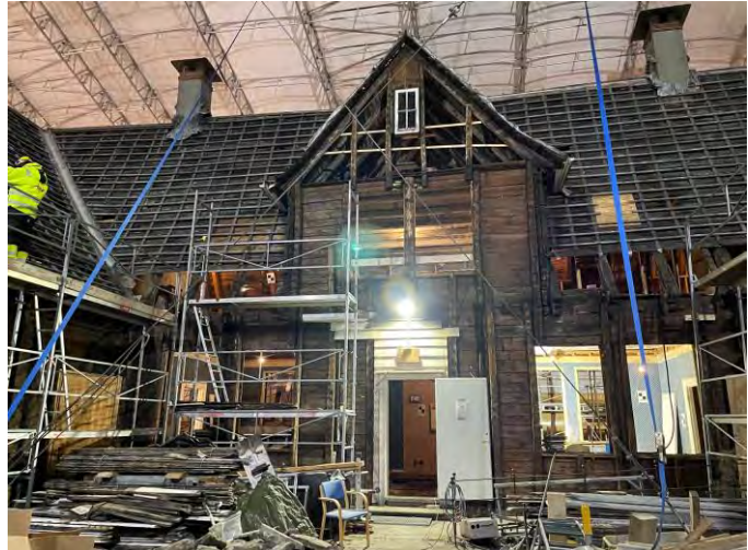
Kulturhuset Danckert Krohn er pakket inn i presenning mens rehabiliteringen pågår. Foto: Wenche Bjørkedal
