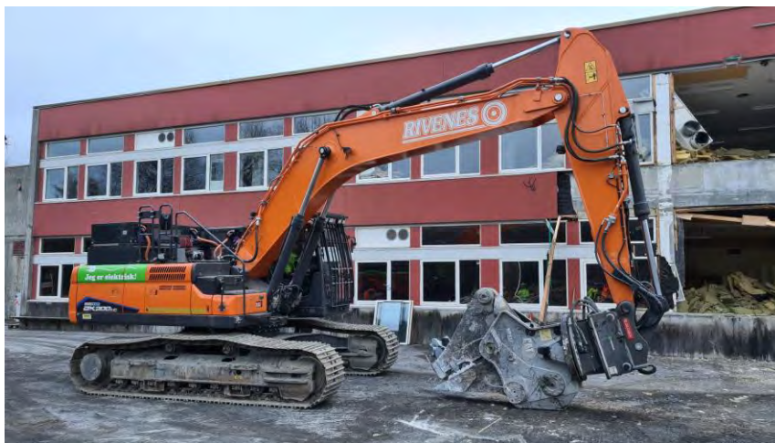
Byggeprosjektet ved Garnes ungdomsskole er et pilotprosjekt for utslippsfri byggeplass. Foto: Henrik Ravndal
