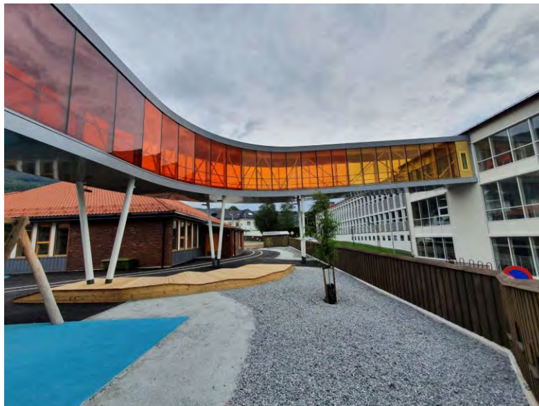
Gangbro, Kronstad Oppveksttun. Foto: Gerd Hole
