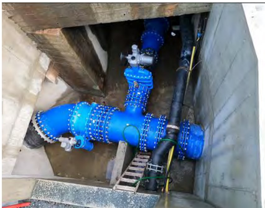
Fornyng vann i Stemmeveien, ny vannkum ved inngangen til tunnel i Stemmeveien. Fotograf: Roger Løseth.
