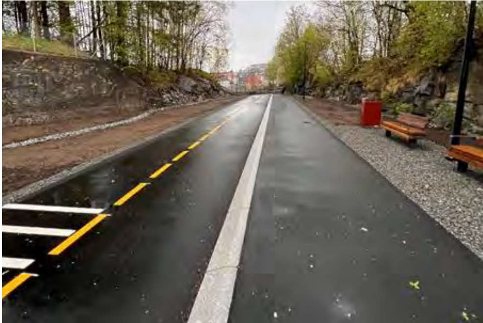
Sykkelveg med fortau etablert på Kronstad i 2022 mellom St. Halvards vei og nytt anlegg ved holdeplass «Kronstad» Bybanen linje 2.
