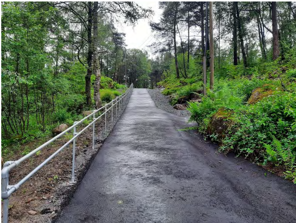
Opprustet gangveg/skoleveg i Loddefjord. Foto: Ida Skålin
