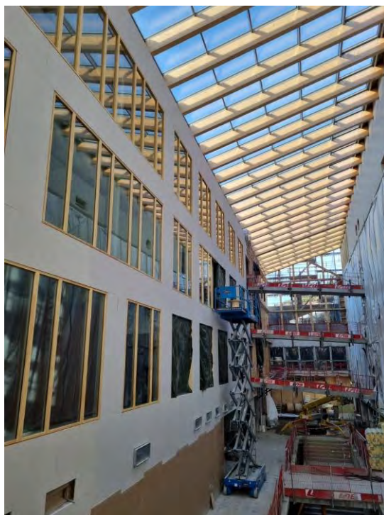
Bilde fra byggeplass - Bergen Inkluderingscenter. Foto: Elena Castillo
