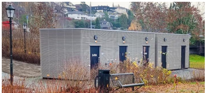
Sundet servicebygg og offentlig toalettanlegg: Bilde: Sven Olav Vahlenkamp
