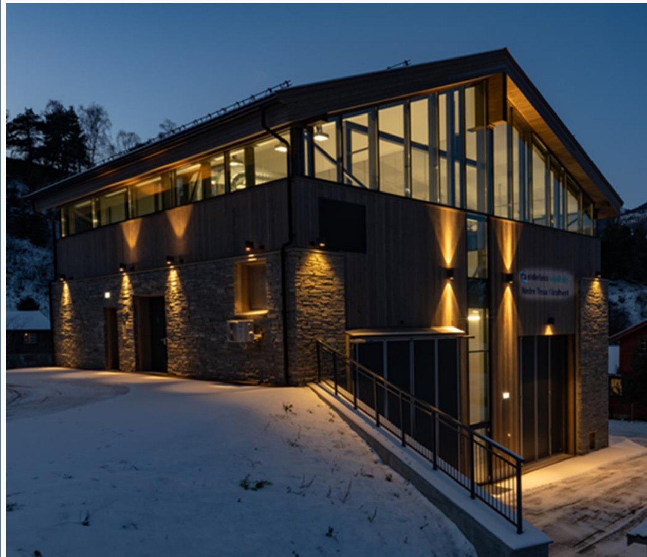
Kraftstasjonen Nedre Tessa 1, stasjonen ble satt i drift i 2021.
