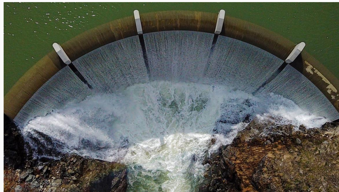
Overløp på dammen i smådøla
