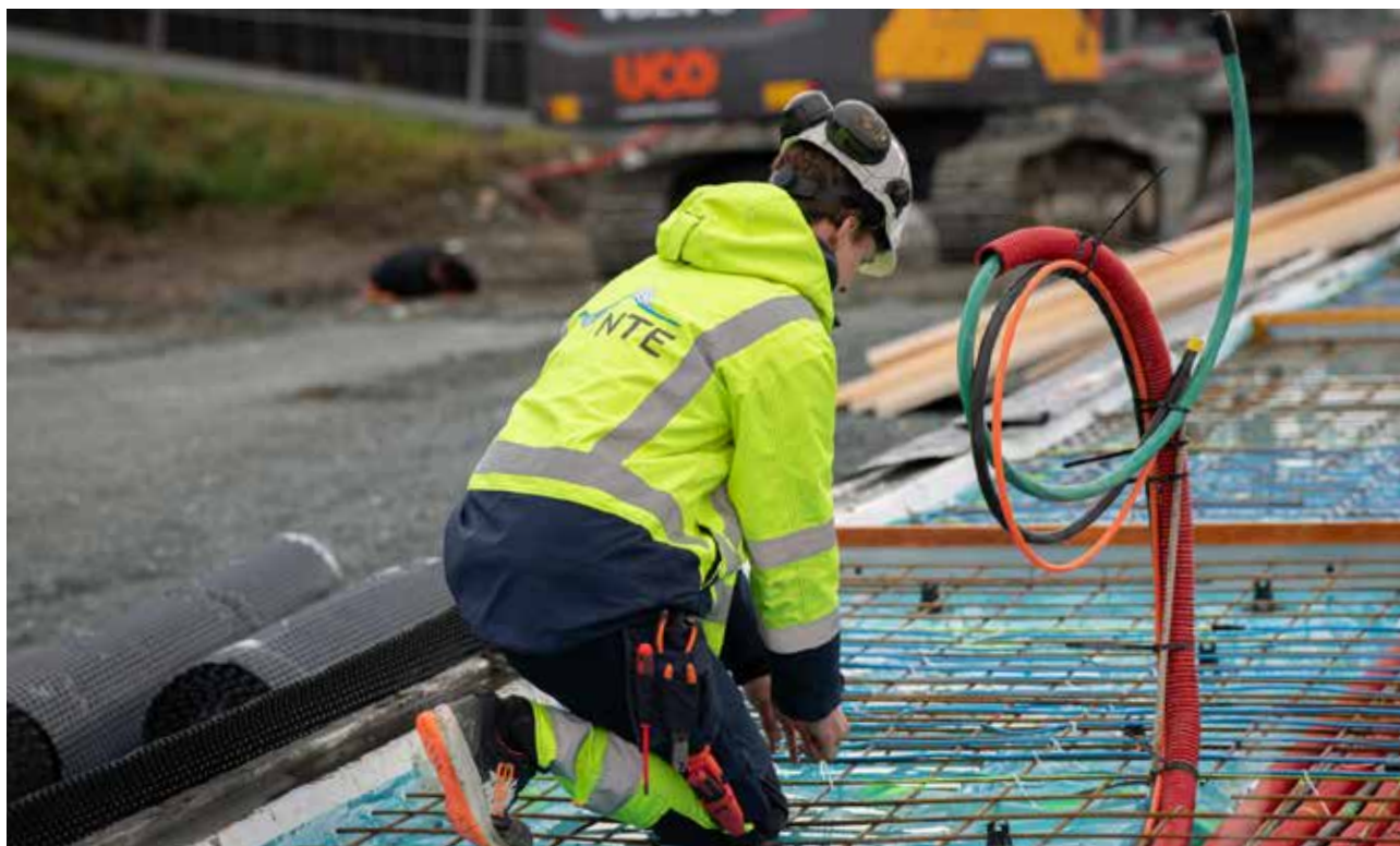
Elektromontør i arbeid
