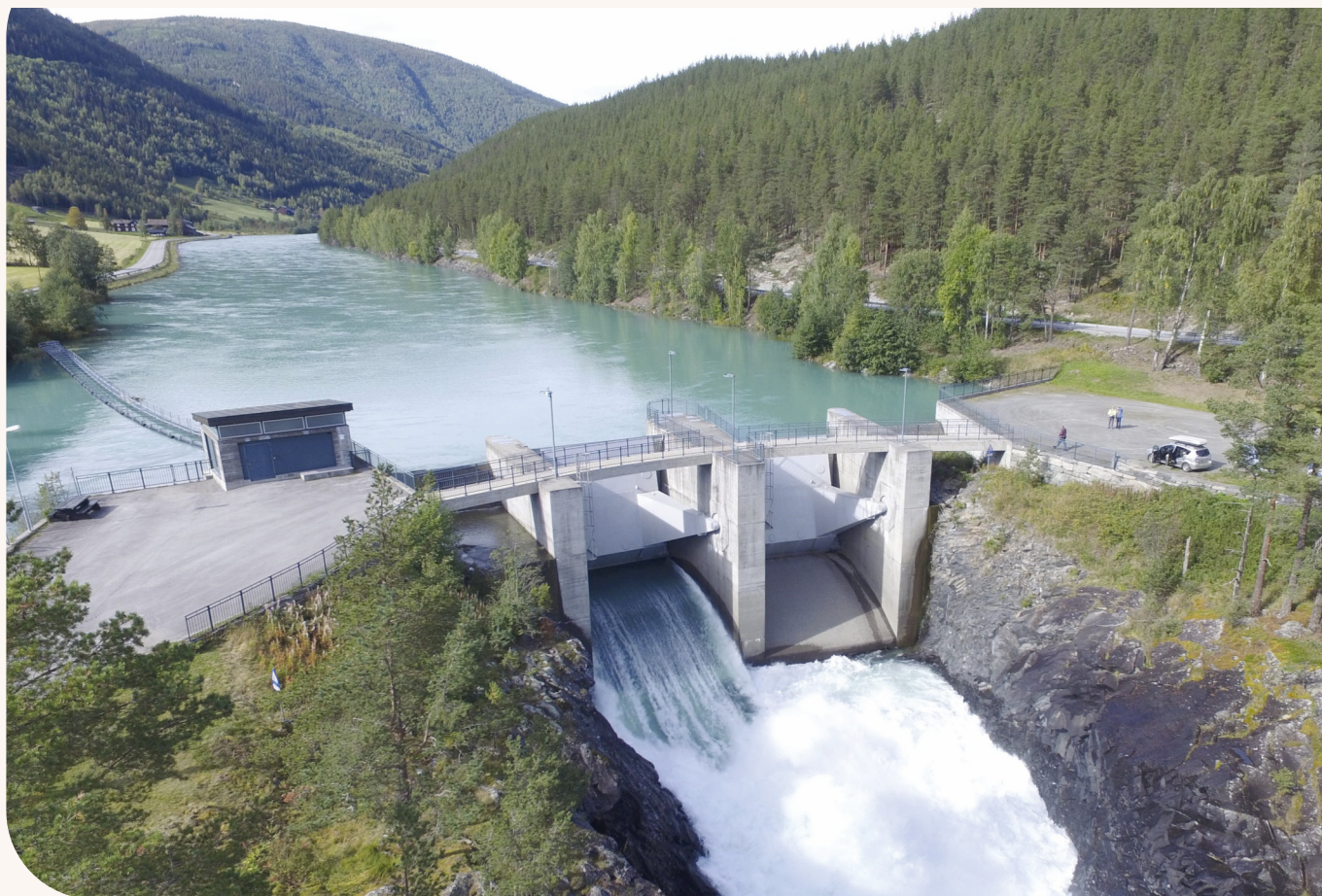
Inntaket i Eidefossen før Nedre Otta-prosjektet vart starta opp. Foto: Eidefoss.
