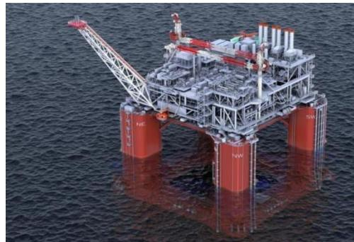
Le développement comprend un système sous-marin à arbre humide connecté à une unité de production flottante (FPU), qui sera reliée à une unité de stockage et de déchargement flottante (FSO), garantissant une extraction et un traitement efficaces des ressources.
