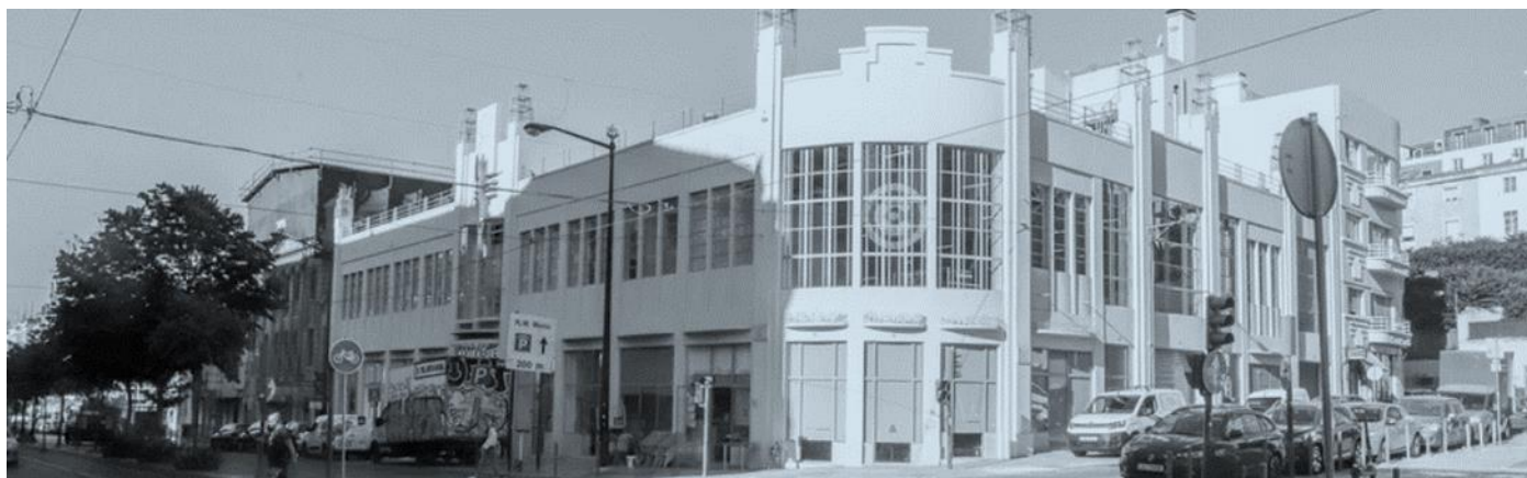
Nova loja Continente Bom Dia no restaurado edifício da histórica Garagem Liz, no centro de Lisboa
