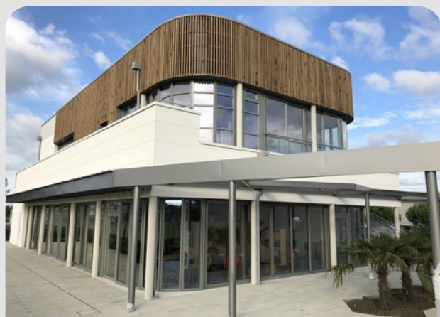
Le bâtiment dédié aux collaborateurs
