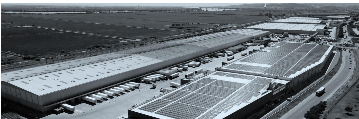
Vista aérea do centro de distribuição da Azambuja, recentemente ampliado
