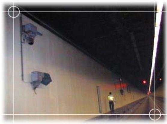
*SANOA T : analyseur multigaz par spectrométrie d'absorption optique différentielle (DOAS UV / Visible), installé en Tunnel.*
