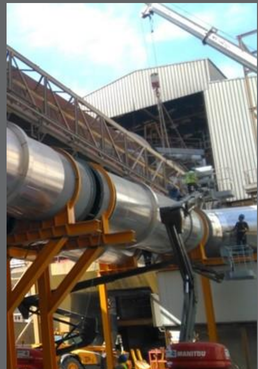
SUBSTITUIÇÃO TÉRMICA EM SOUSELAS
