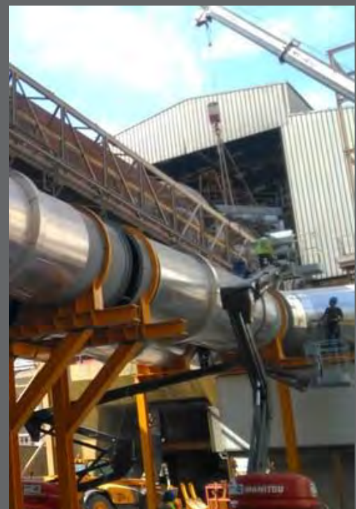
SUBSTITUIÇÃO TÉRMICA EM SOUSELAS
