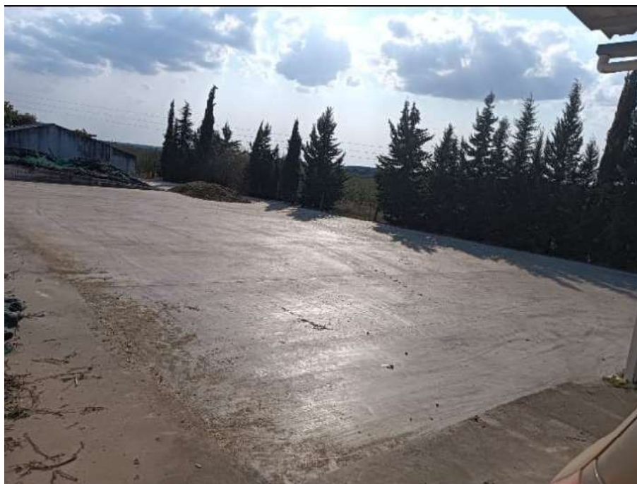
Eira (logradouro cimentado)
