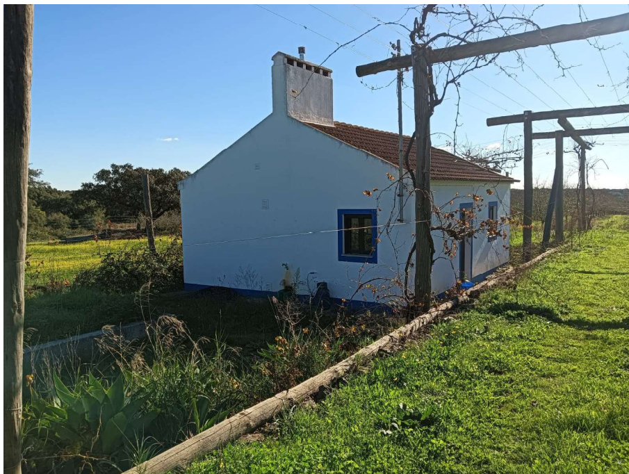
Casario lateral armazéns
