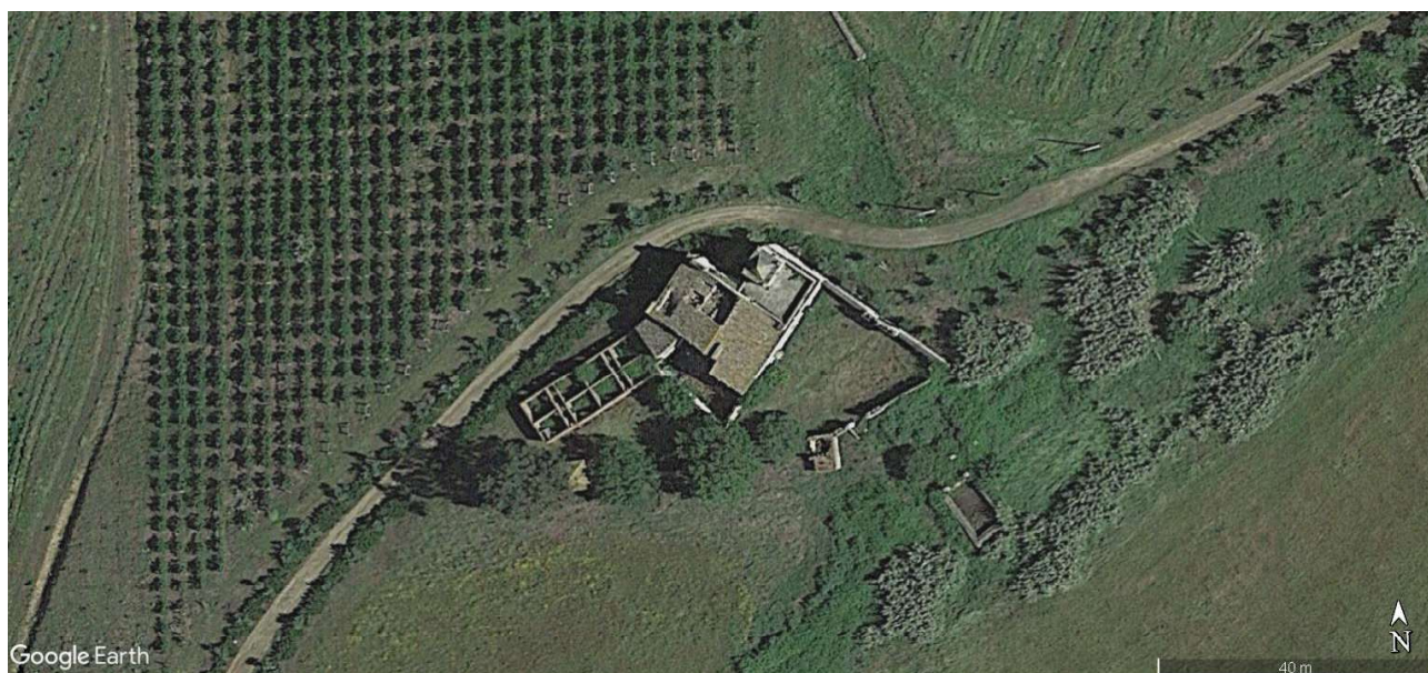
Área da casa principal original da herdade, presentemente em estado não habitável – Artº 203 Urb.
