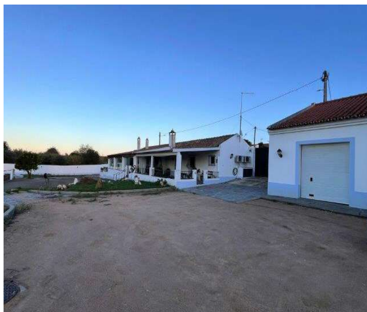
FACHADA SALA PROVAS, LOJA E ESCRITÓRIO
