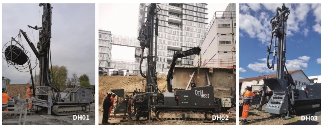
Crédits : Arverne Drilling
