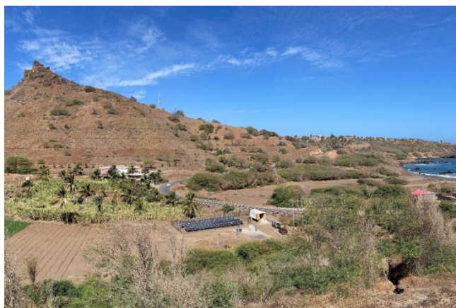
Projet de dessalement d'eau saumâtre solaire OSMOSUN® pour l'agriculture à Moia Moia, financé par le FIDA
