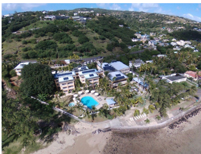
Maurice : Installation OSMOSUN® alimentant l'hôtel en eau douce, avec le solaire en toiture
