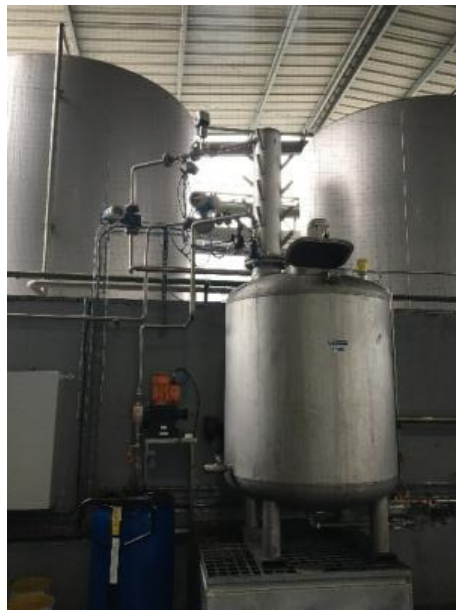
Poste automatisé de dilution des concentrés
